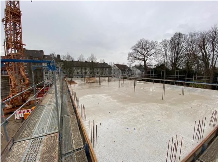
Die Fotos zeigen den Stand vom 23.12.2020 (hier wurde die Decke im EG in Beton gegossen).
